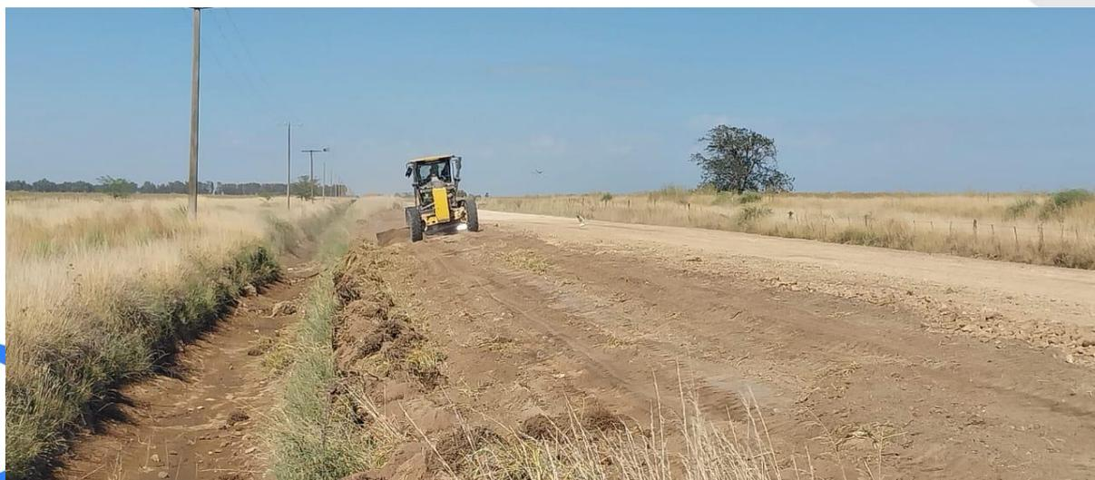
**MOTONIVELADORA 2:** Como dato relevante de esta semana, esta motoniveladora se trasladó al camino 78-1-104 (Frontera Sur). Allí se iniciaron tareas de reconformado aprovechando la humedad existente. Se irá avanzando desde ruta 51, empezando por la parte crítica más afectada, y dicho avance dependerá del grado de humedad del suelo.
