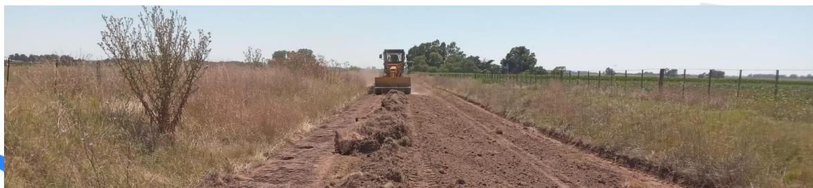
**RETROEXCAVADORA MUNICIPAL:** Este equipo inició tareas de entoscado y formación de cunetas en el camino 78-3-37b (camino a 16 de julio – Zona El Perdido). Se está realizando un importante movimiento de suelo, a fin de garantizar el escurrimiento del agua, y a su vez, la extracción de tosca para mejorar la transitabilidad. Además, se realizaron tareas de desmonte en una zona donde las plantas impedían el escurrimiento del agua.
